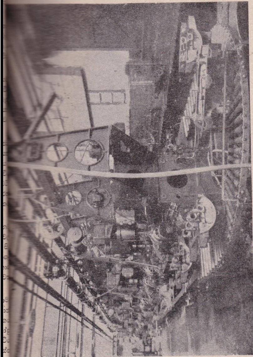
1 වැනි පුරාව. — නියම කමහල් සියයුම මුලින් ම යෙදවූ මෝටර්ස් සමාගමයි. 1923 දී ඔවුන්ගේ මුල් ම මාරු යන්ත්‍රවලින් එකක් ඔලින්ඩර් කඳන් සෑදුනු මෙහි පෙනේ. පසුබිමෙහි දක්වෙන වාහක පටිය මත කඳන් සමහරක් වටේ යනවා දක්නට තිබේ.
